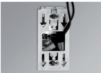
6. Coloque todos los cables en la caja de conexiones.
